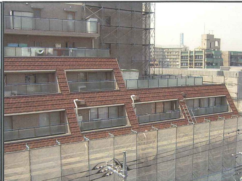
斜壁 板金施工完了
