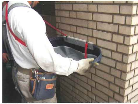
外壁タイルのハツリ作業に
