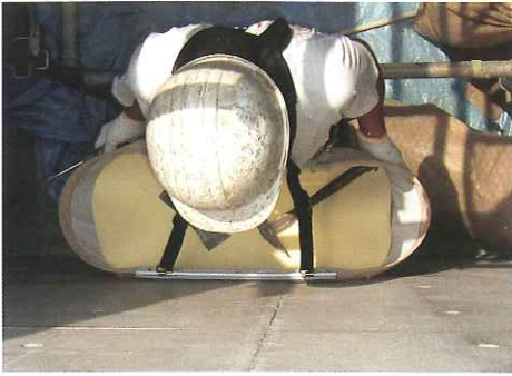
外壁設置状況
