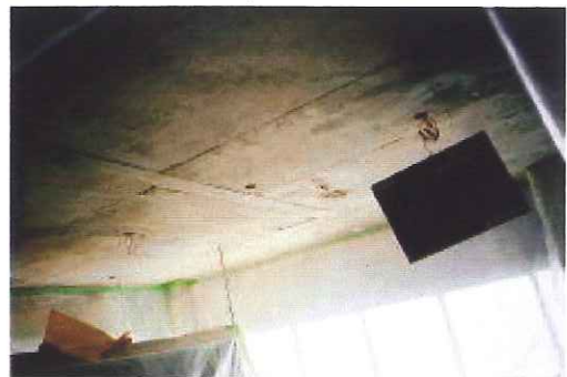
アスベスト除去終了 作業後 アスベスト粉じん濃度測定
