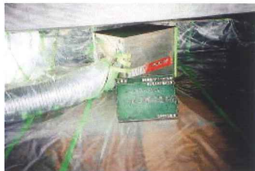
作業場所の換気回数が最低 毎時4回以上となるよう計算して設置
