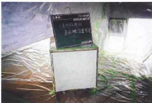
作業中のアスベスト飛散防止 負圧除じん装置の設置
