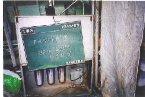
セキュリティームシャワー 洗浄水の排水ろ過フィルター
