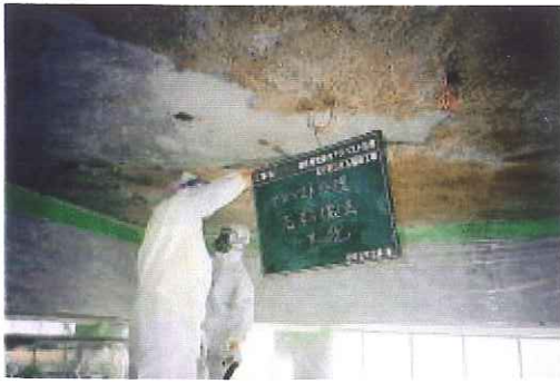
アスベスト除去 作業中 アスベスト粉じん濃度測定
