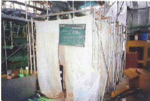
アスベスト除去作業員のセキュリティーム
